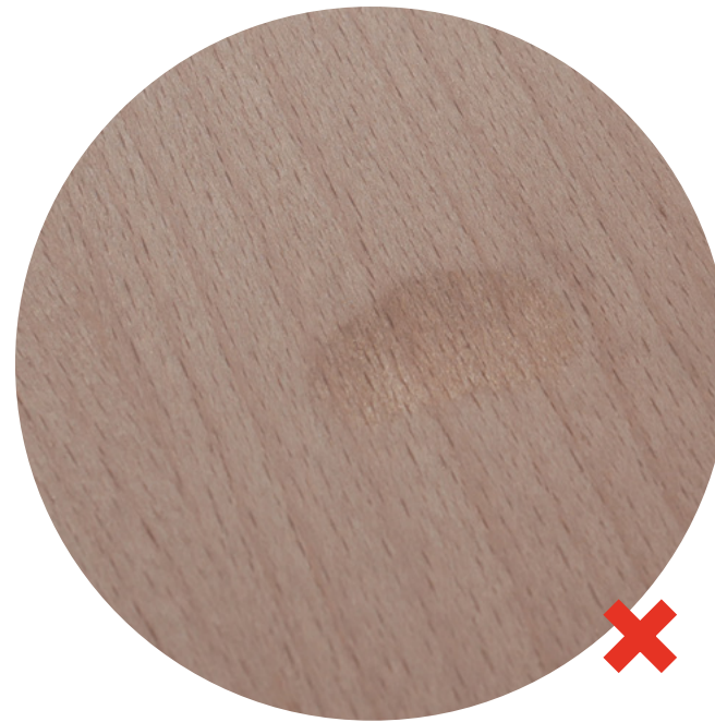
Wgniecenie okleiny wynikające z nieuzupełnionego ubytku wkładu
