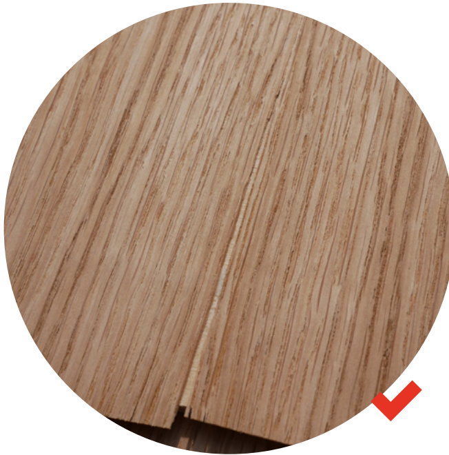
Pęknięcia i niedokładne spajanie
